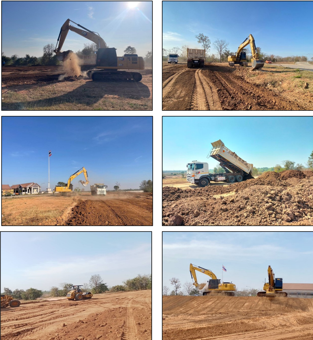
รูปที่ 5.1.7-1 งานดินซุด และงานดินถมบดอัดแน่น
